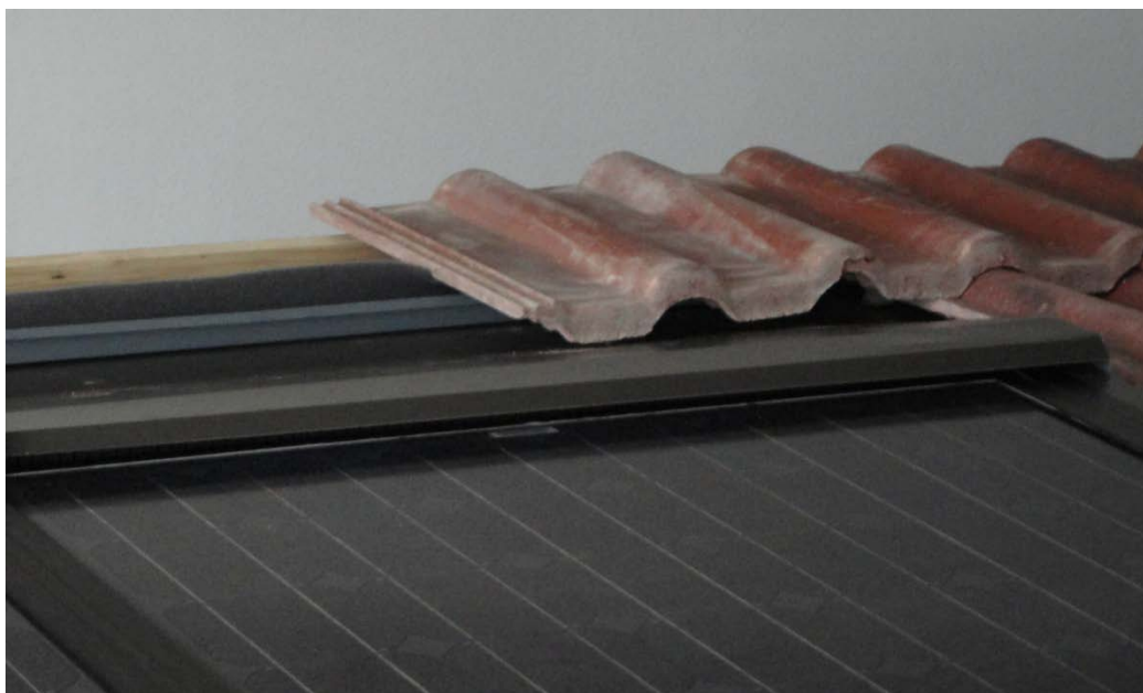
Figure 29 : Repose des tuiles en haut de champ
