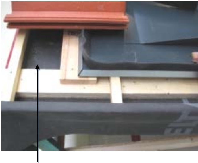
Figure 11 : Planche de renfort pour les tôles d’étanchéité supérieures
